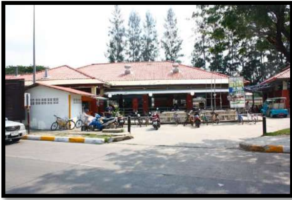
ภาพที่ 3 บาทวิถีที่ขาดความต่อเนื่อง หรือป้ายเตือนอาจเกิดอันตรายได้
