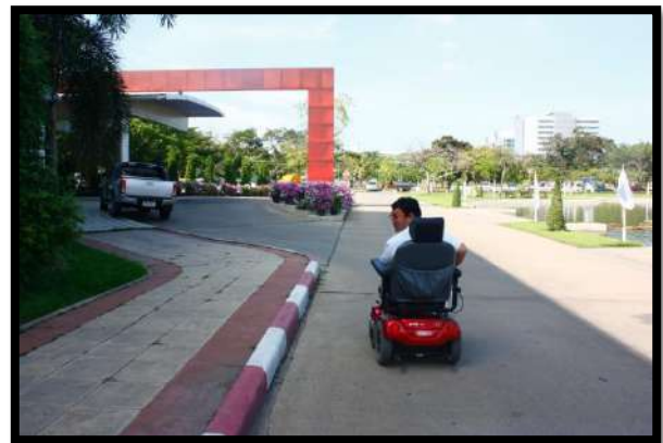
ภาพที่ 2 บาทวิถีไม่มีทางลาดตัดขอบถนน ทำให้เก้าอี้ล้อคนพิการสัญจรไม่ได้ และจักรยานต้องใช้ทางร่วมกับรถยนต์
