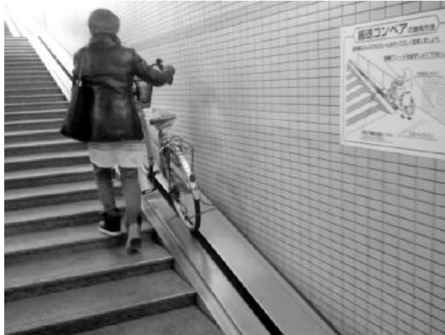
รูปที่ 1 การออกแบบร่องระบบสายพานสำหรับจักรยานภายในสถานีรถไฟใต้ดิน ประเทศญี่ปุ่น (ภาพจากawordfromjapan.wordpress.com)
