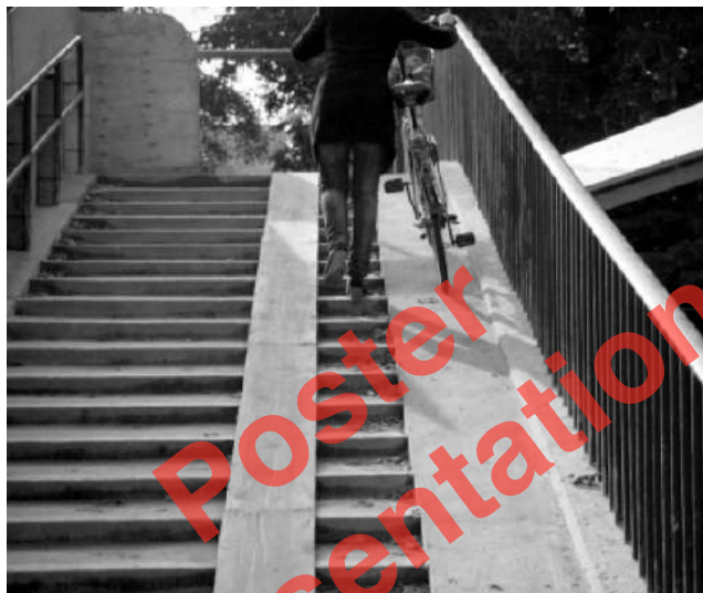
รูปที่ 2 ออกแบบทางลาดสำหรับจักรยานควบคู่ไปกับตัวบันได ในเมือง Copenhagen (ภาพโดย Colville Andersen)
