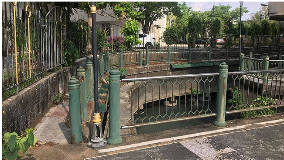
เส้นทางเดินริมคลองห้วยยาง บริเวณถนนห้วยยอด
